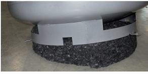
Nach dem Öffnen der Verpackung Bodenwärmedämmung und Umrandung richtig platzieren.
