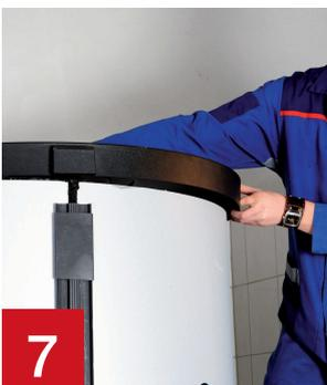
Den Deckel mit den Hakenleisten-Ausnehmungen oben auf der Wärmedämmung richtig positionieren und anbringen.
