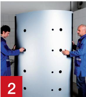
Den gelochten Wärmedämmungsteil mit dem Vlies nach innen über die Anschlüsse aufziehen.
