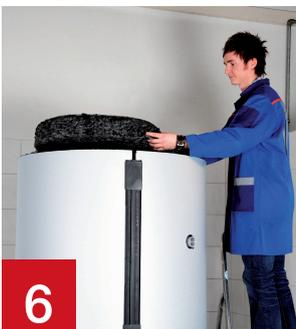
Die Rondelle oben am Speicher einlegen und durch leichtes Andrücken positionieren.
