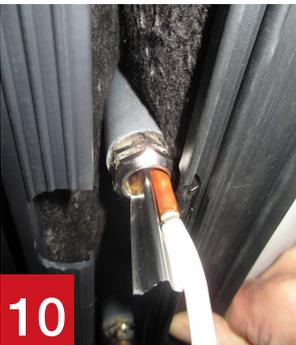
Montage der Fühler mit der beiliegenden Tauchhülsenfeder. Es können insgesamt 3 Fühler pro Tauchhülse montiert werden.
