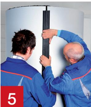
Nach dem Anbringen der Abdeckleiste kann die Wärmedämmung mittels der zweiten Hakenverschlussleiste geschlossen werden.
