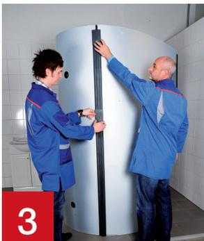
Ungelochten Wärmedämmungsteil an der Hakenverschlussleiste des bereits aufgebrauchten Wärmedämmungsteils einrasten.
