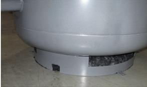
Um eine ordnungsgemäße Montage durchführen zu können, muss das Gerät vor der Montage der Wärmedämmung waagrecht ausgerichtet werden.
