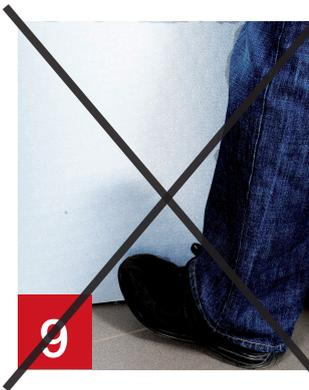
Die Wärmedämmung darf nicht geknickt oder eingedrückt werden, es besteht Beschädigungsgefahr (Weißbruch). Ein durch unsachgemäße Behandlung entstandener Weißbruch kann mittels Heißluftföhn vorsichtig beseitigt bzw. minimiert werden.
