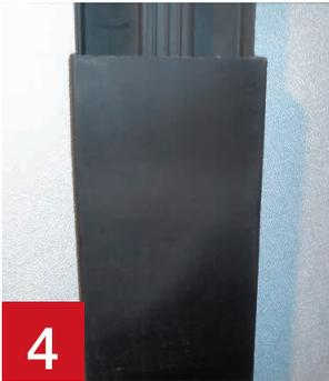
Um ein Öffnen der Hakenverschlussleiste während des weiteren Montagevorganges zu verhindern, sollten die mitgelieferten Abdeckleisten über die Hakenverschlussleiste eingerastet werden.
