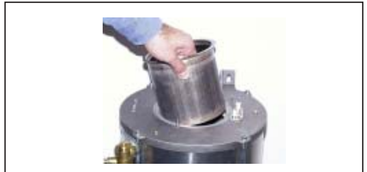
Bild: Brenner nach oben herausnehmen
