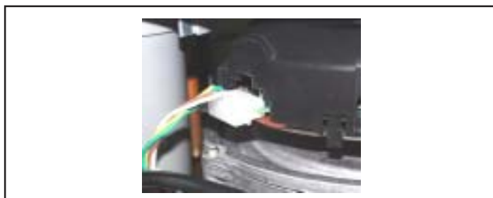
Figura: Linea di comando al ventilatore
