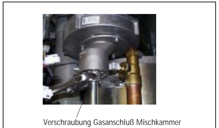
Bild: Verschraubung Gasanschluß Mischkammer
