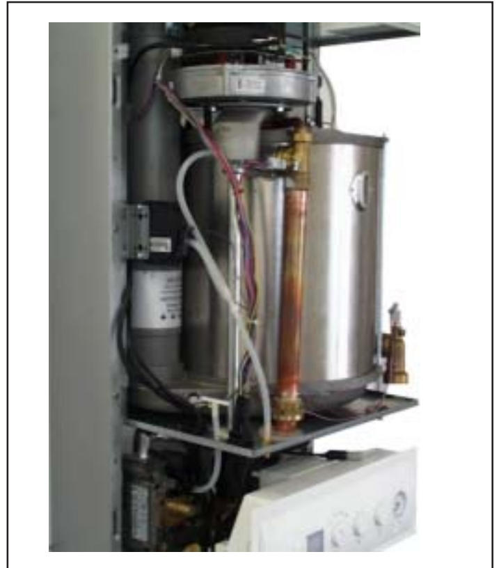
Fig: Posición conductos neumaticos de regulación
