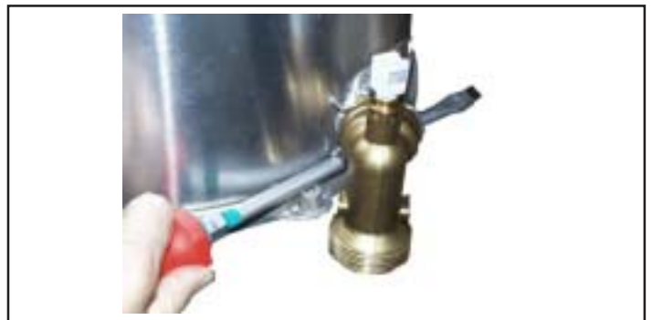
Figura: Togliere lo scambiatore primario dal collettore di condensa
