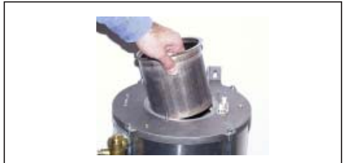
Fig.: Estrarre il bruciatore verso l'alto
