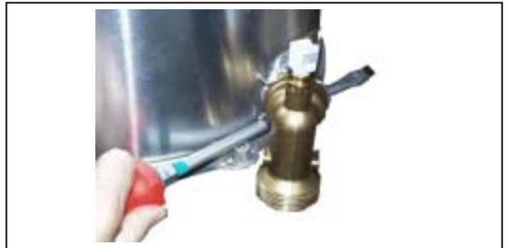
Bild: Wärmetauscher von der Kondensatwanne lösen
