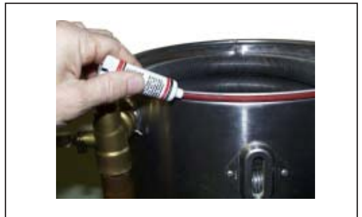
Fig: Engrasar todas las juntas con silicona.
