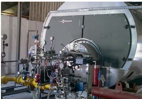
Wasserstoffbefeuerter Dampfkessel – Anlage der National Chlorine Industries (NCI) in Jordanien, Hersteller für Chlor in der chemischen Industrie und für Wasseraufbereitungsprojekte
