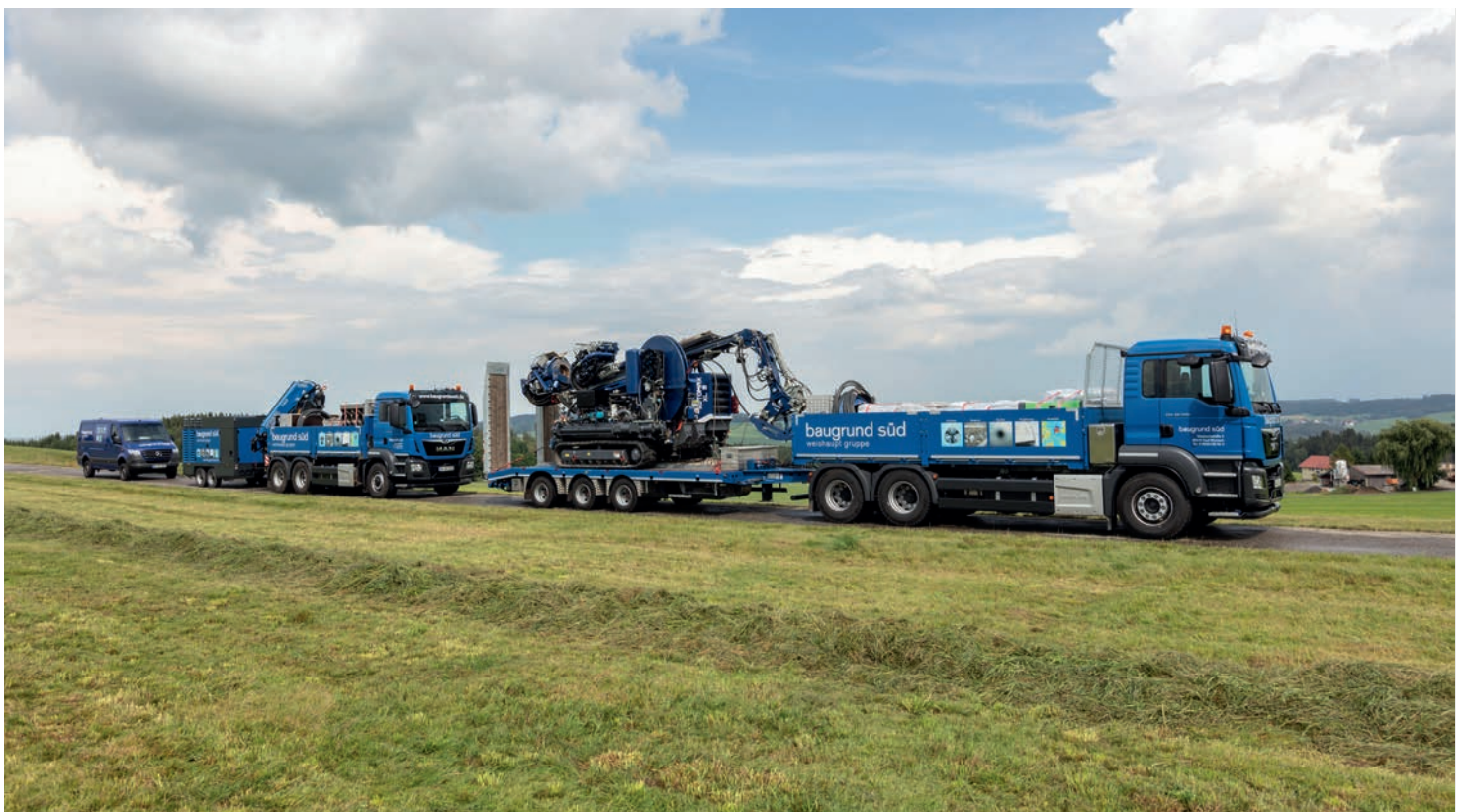
BauGrund Süd verfügt über eine Erfahrung aus mehr als 22.500 erstellten Anlagen und weit über 3 Millionen Bohrmetern
