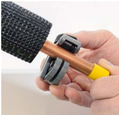
1. Ablängen der Leitung
