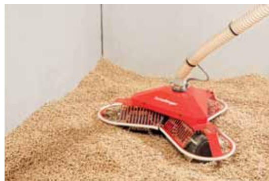
Lagerraum mit Zuführung zum Pelletkessel durch Maulwurf-System
