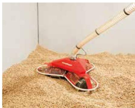
Lagerraum mit Zuführung zum Pelletkessel durch Maulwurf-System
