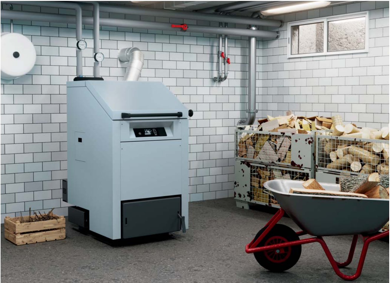
Scheitholz-Vergaserkessel Vitoligno 300-S – manuell von oben beschickbar
